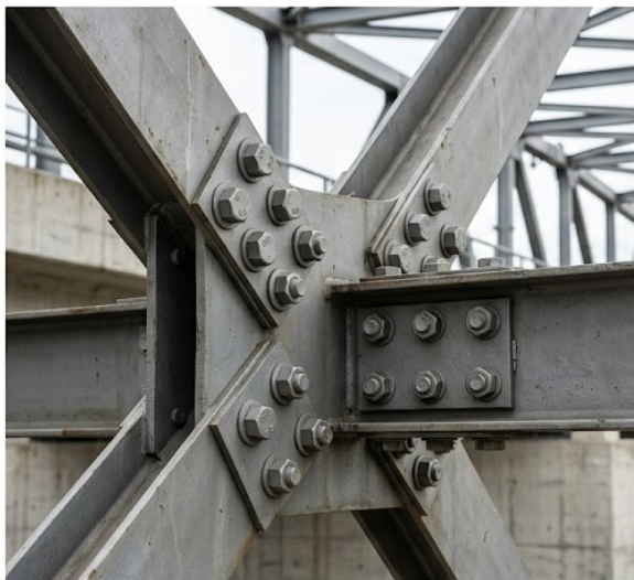
Рис. 3.2а. РЕАЛЬНИЙ БОЛТОВИЙ ВУЗОЛ.
