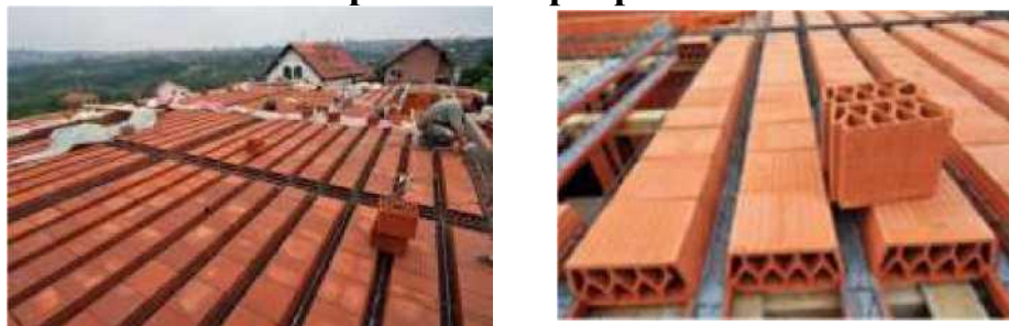
Рис. 6.21. Конструкція керамічного перекриття Nexe
