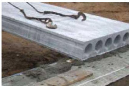
Рис. 6.22. Спирання плити перекриття на стіну
