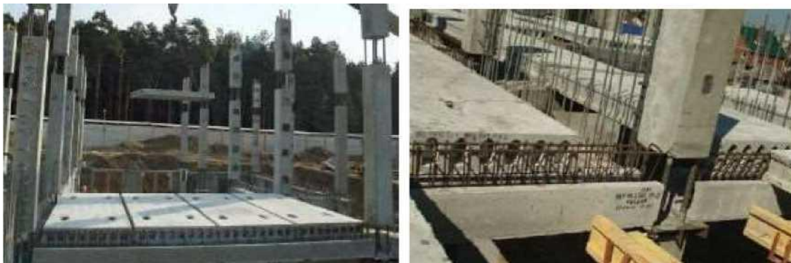
Рис. 6.16. Збірно-монолітне міжповерхове перекриття житлових будинків
