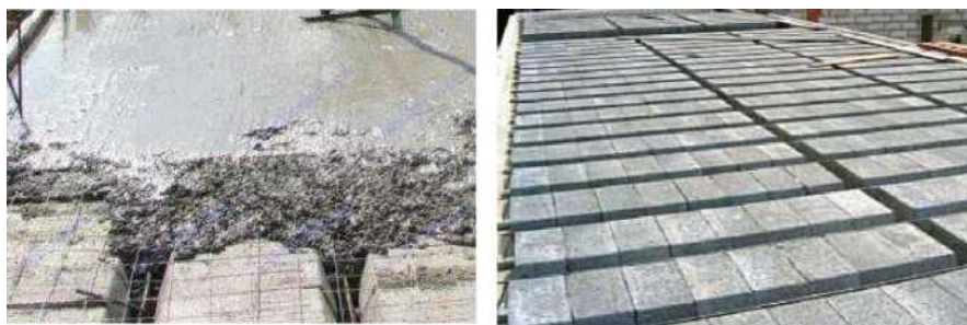
Рис. 6.17. Перекриття із збірно-блокових плит
