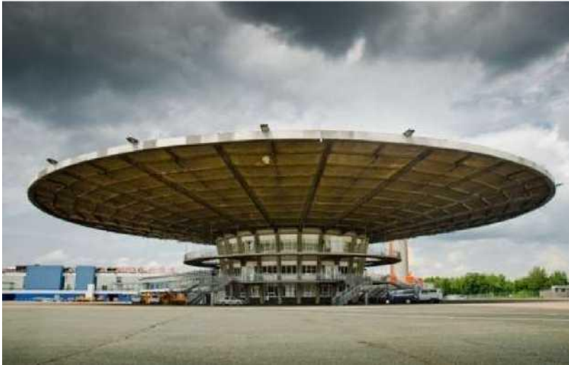
Рис. 3.2.43. Посадочний павільйон аеропорту «Шереметьєво» в Москві
