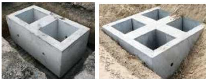
Рис.4 12, а. Спарений фундаментний стакан (з випусками арматури),
