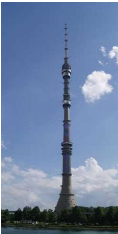
Рис. 3.2.42. Телевізійна вежа в Останкіно (Москва). Архітектор Л. Баталов, інженер Н. Нікітін.
