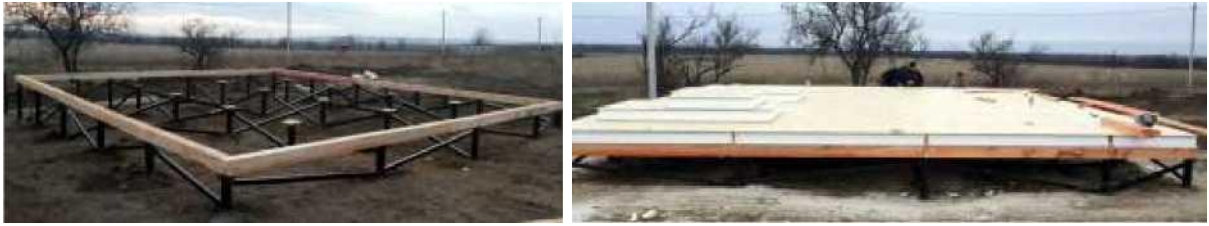
Рис.6.6. Влаштування фундаменту та СІП - панелей
